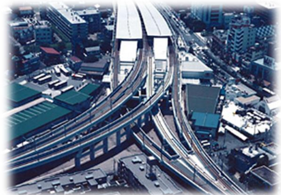
↑実際の鉄道の事例：東急電鉄（写真は二子玉川駅）
